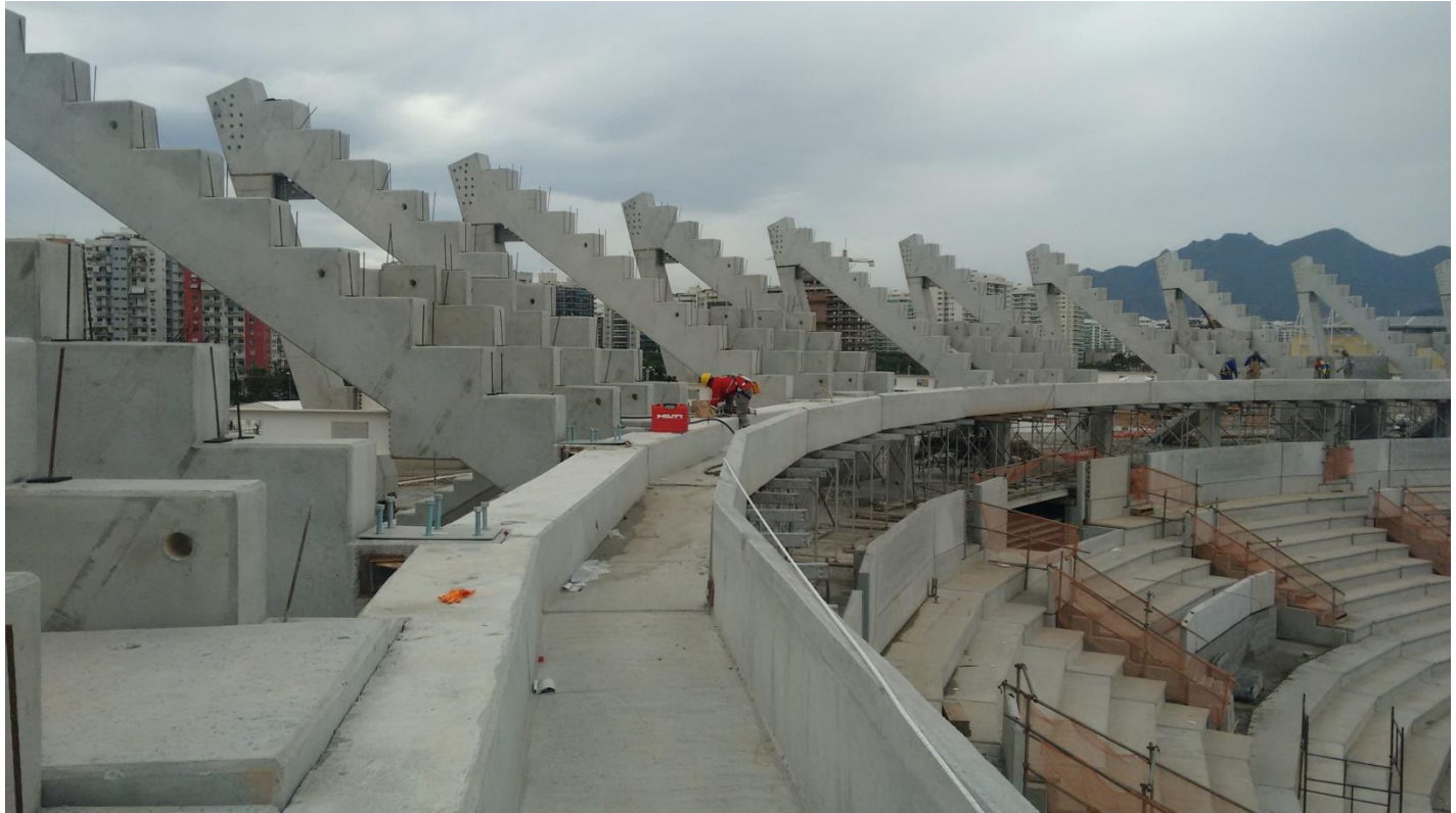
Montagem Arena do Tenis
