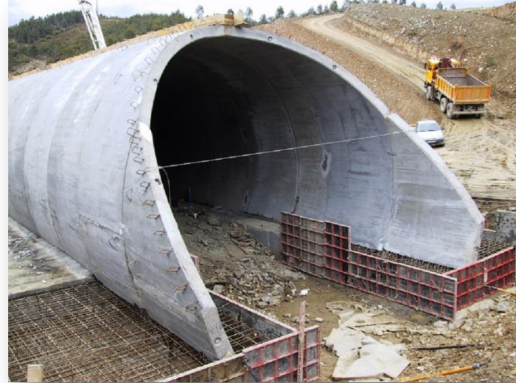
Túneis e Revestimentos
