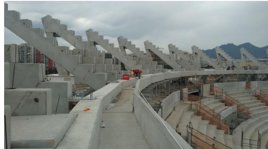
Arena do Tênis RJ - Montagem
