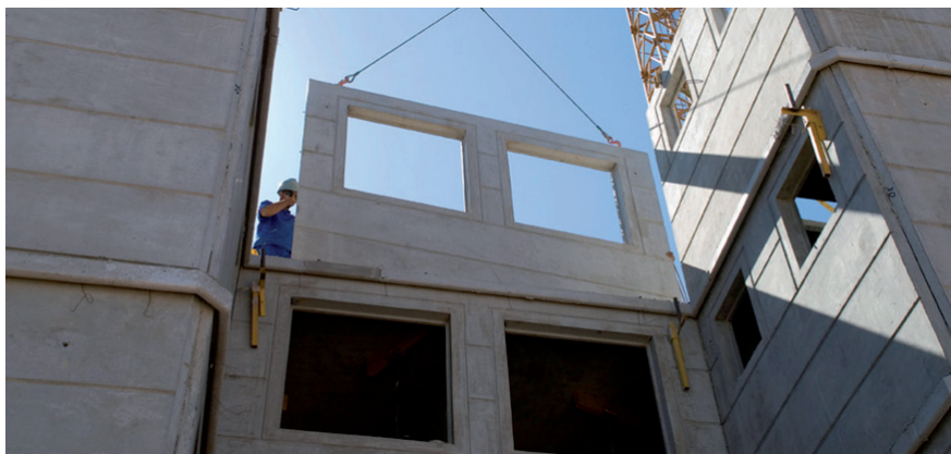
▲ Pré-fabricado otimiza construção de obras habitacionais
