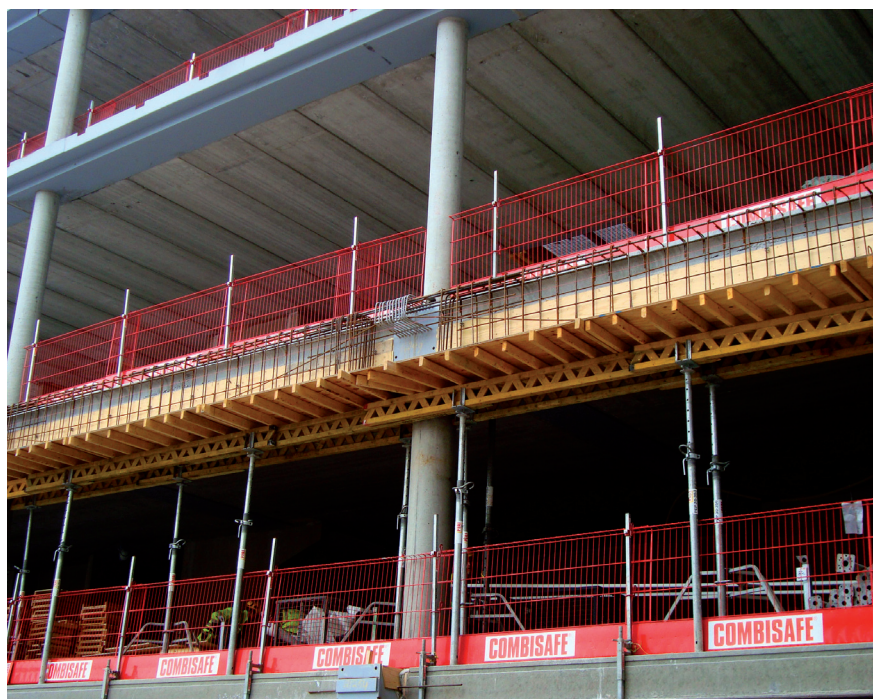
▲ Construção de edifício comercial em pré-fabricados de concreto
