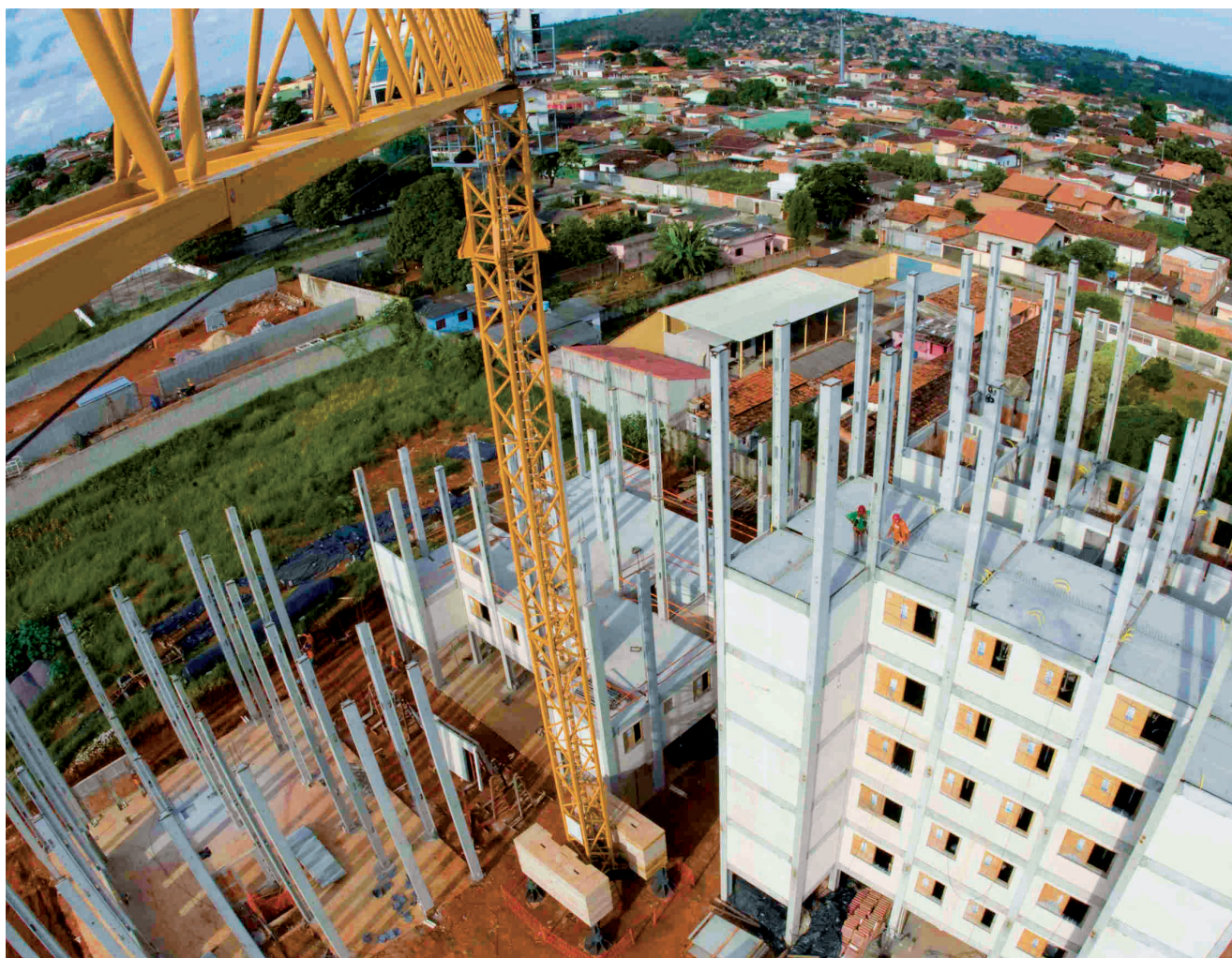
▲ Empreendimento em execução adotando o Sistema Habitacional da Precon Engenharia ▲ Enterprise at execution adopting the Precon Engenharia Housing System
