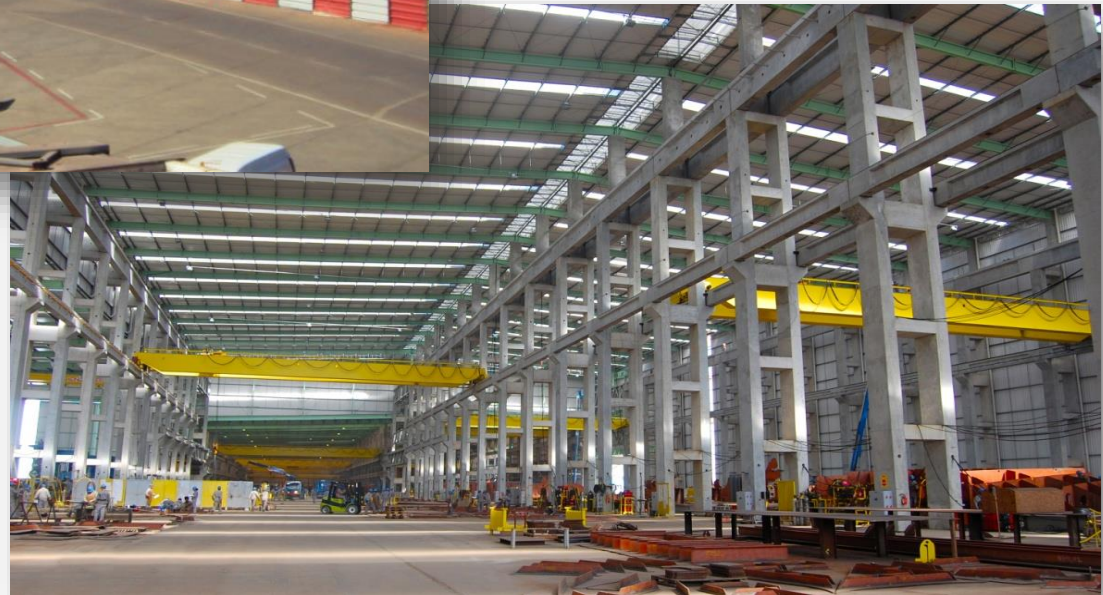
Estaleiro Atlântico Sul Suape/PE
