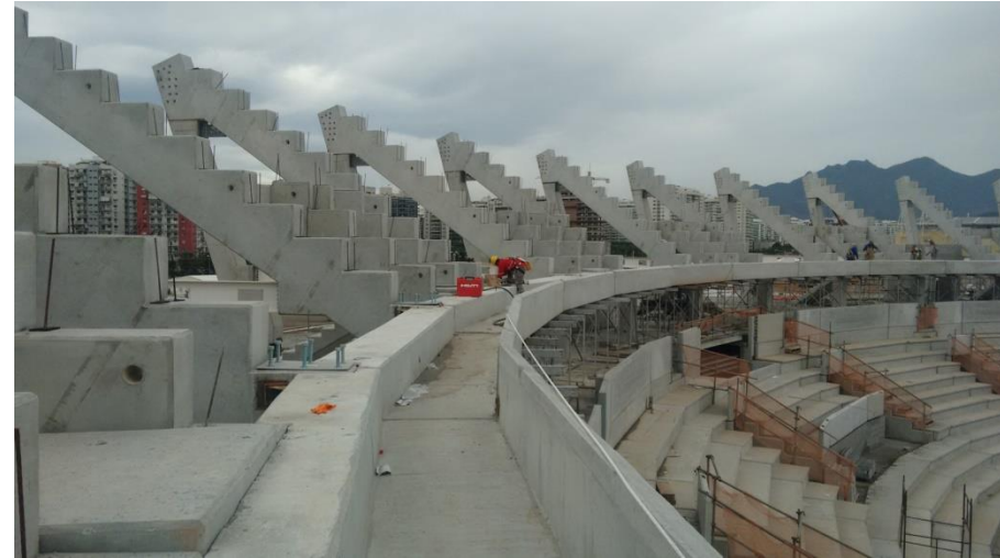
Arena do Tênis RJ - Montagem
