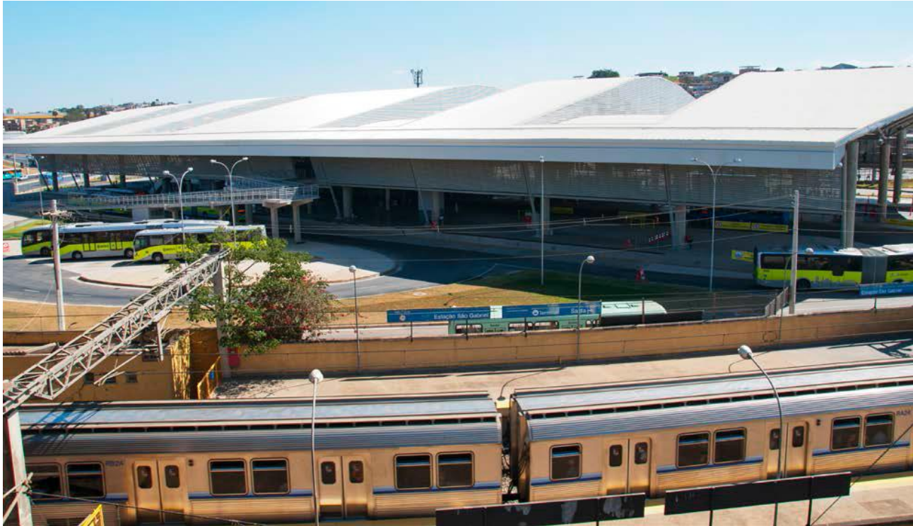
Terminais Rodoviários Urbanos de Integração do BRT de Belo Horizonte
