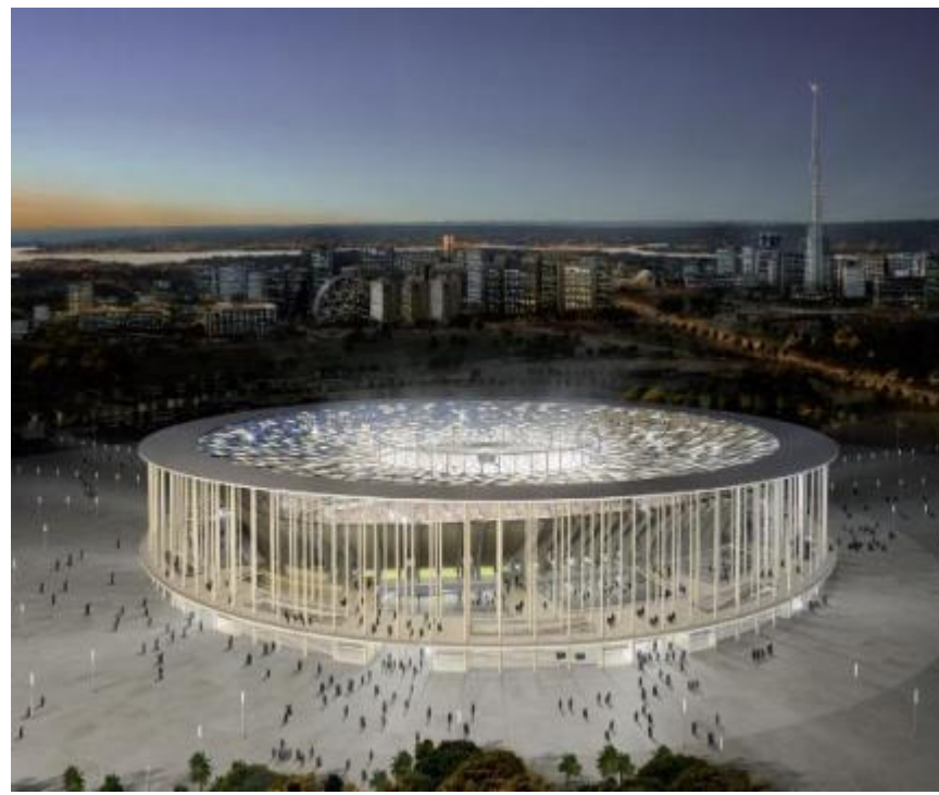
Sede Brasília: Nova Arena Mané Garrincha Castro Mello Arquitetos
