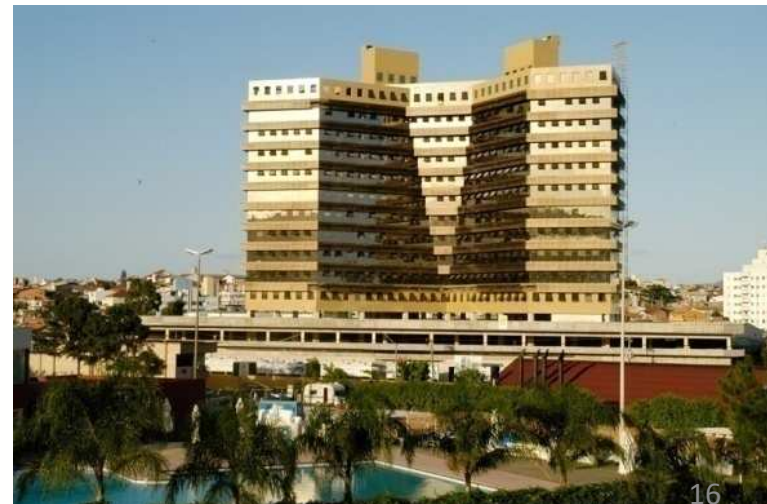
EDIFÍCIO COMERCIAL– Jaraguá do Sul-SC)
