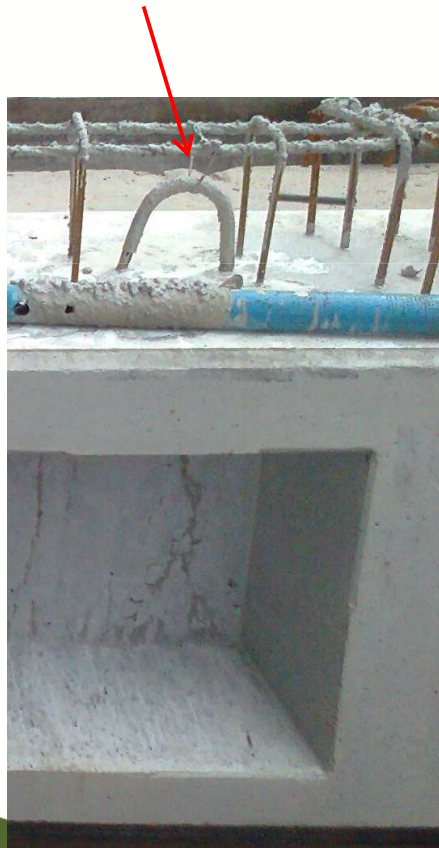
Alça produzida com cordoalha CP-190+ tubo.
