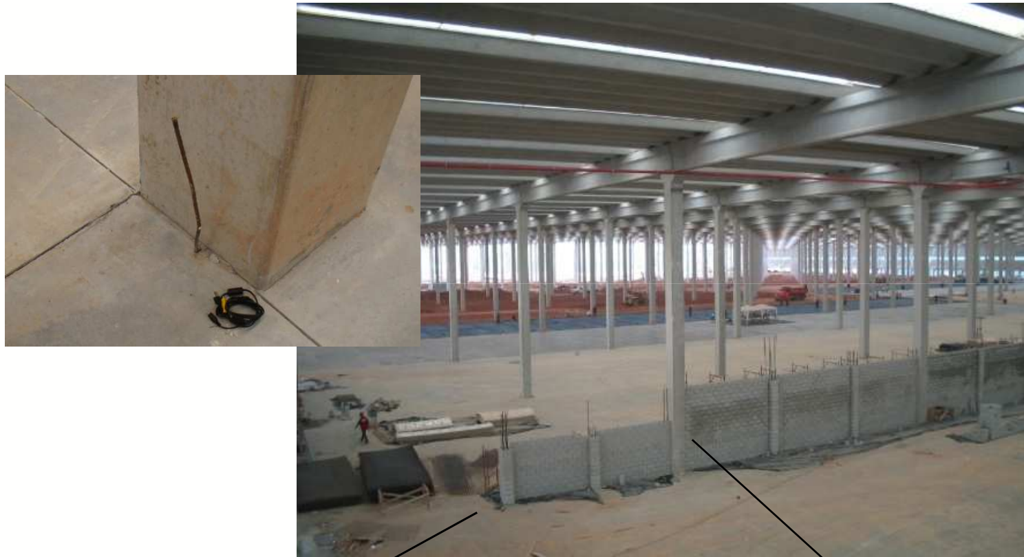
Alvenaria de Blocos
