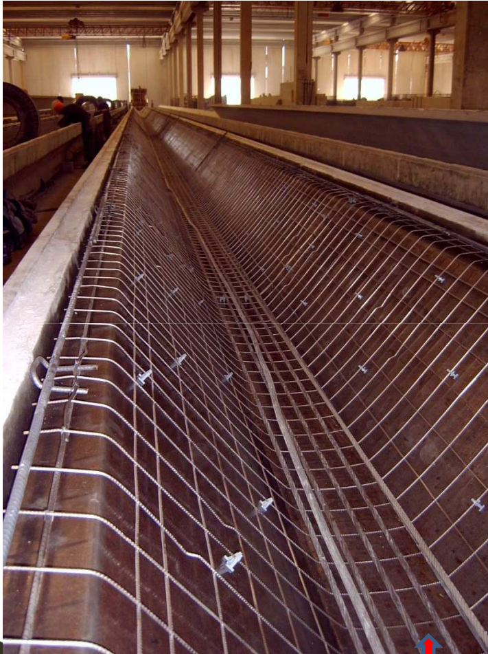
Pista de Telhas.
