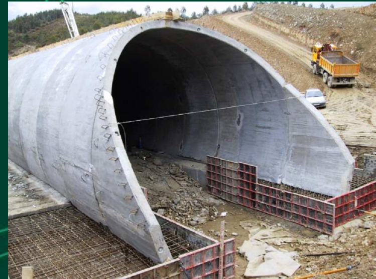
Túneis e Revestimentos
