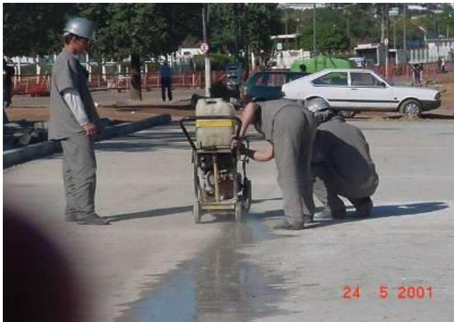
Juntas de retração (6 mm)
