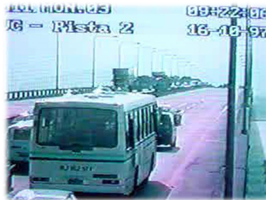
Ponte Rio-Niterói - Rio de Janeiro / RJ - (Vão central em concreto)
