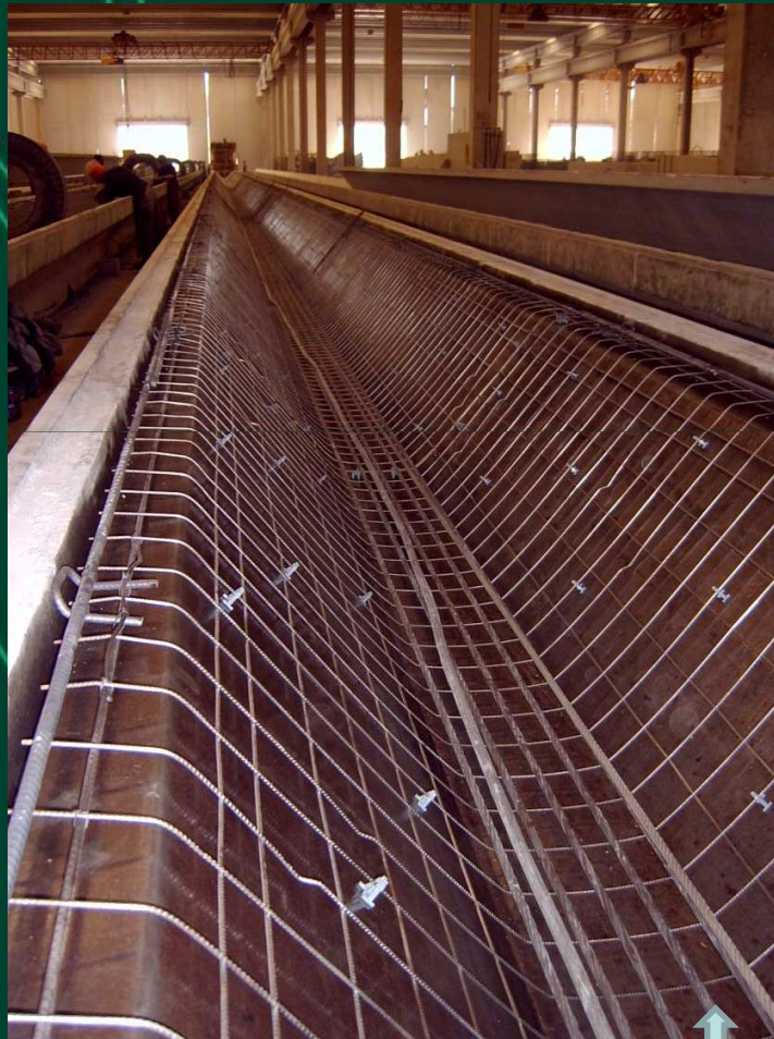
Pista de Telhas.
