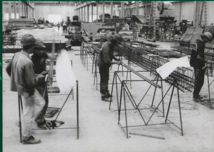
Central de armação. Equipamentos para corte e dobra.
