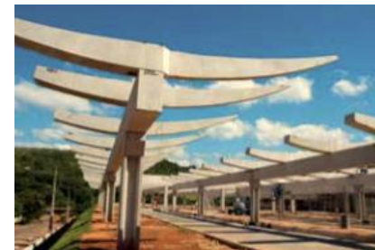
Figura 07. Pórtico de concreto pré-moldado das linhas urbanas em Belo Horizonte.
