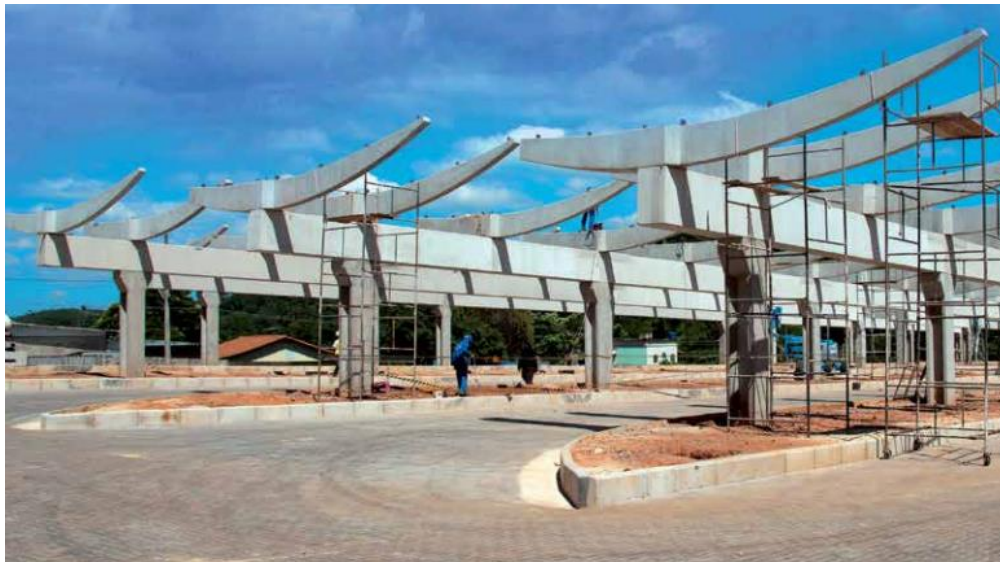
Figura 07. Pórtico de concreto pré-moldado das linhas urbanas em Belo Horizonte.
