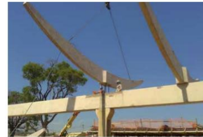
Figura 07. Pórtico de concreto pré-moldado das linhas urbanas em Belo Horizonte.
