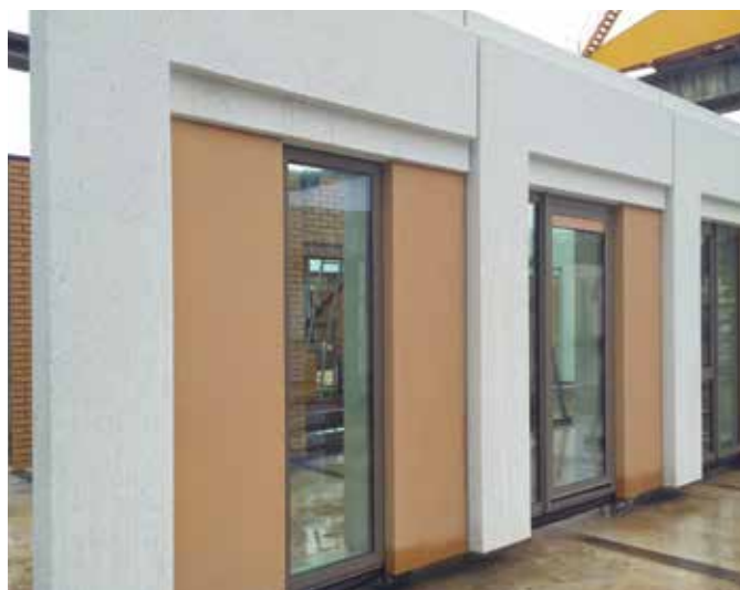
VISITA À FÁBRICA HURKS PREFABBETON - LOCHT HOLANDA
