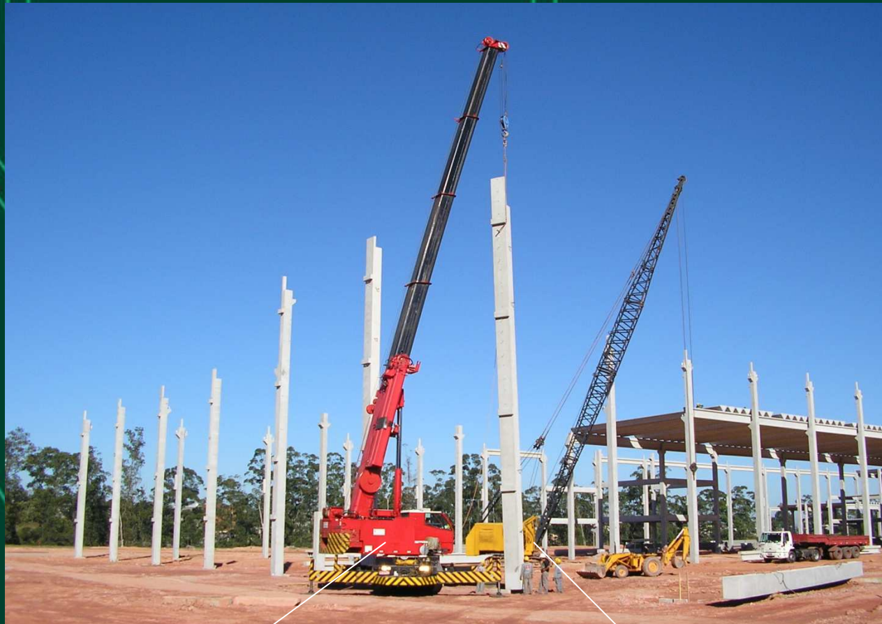
Autogrua sobre pneus.
