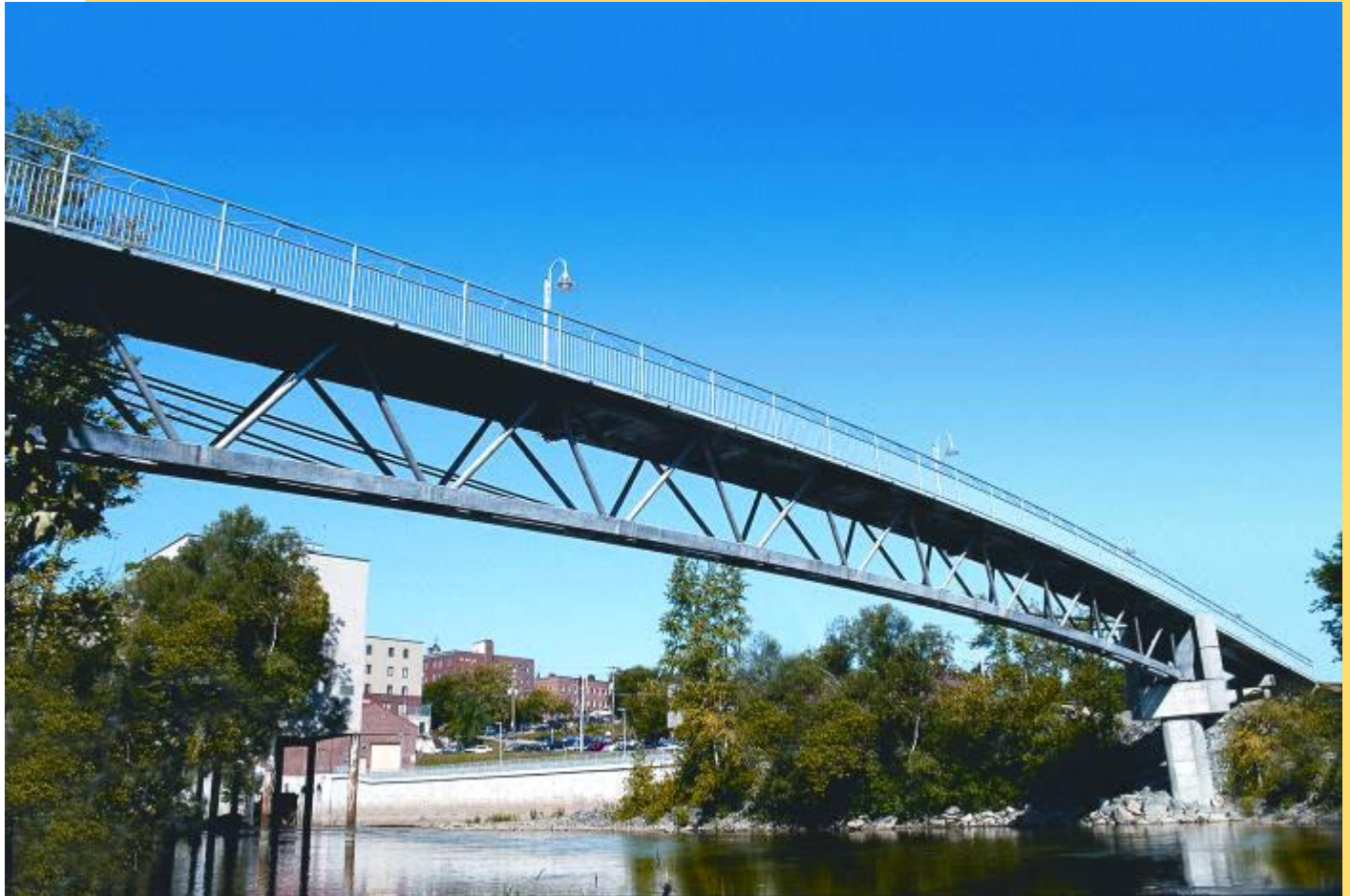
Passarela de Sherbrooke (Sherbrooke, Canadá)
