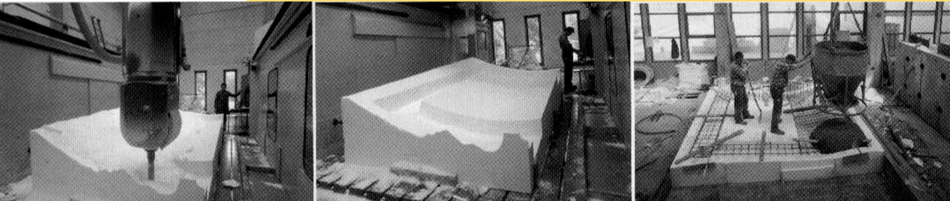
Torres Zollhof (Düsseldorf, 2000) - moldes para painéis de concreto
