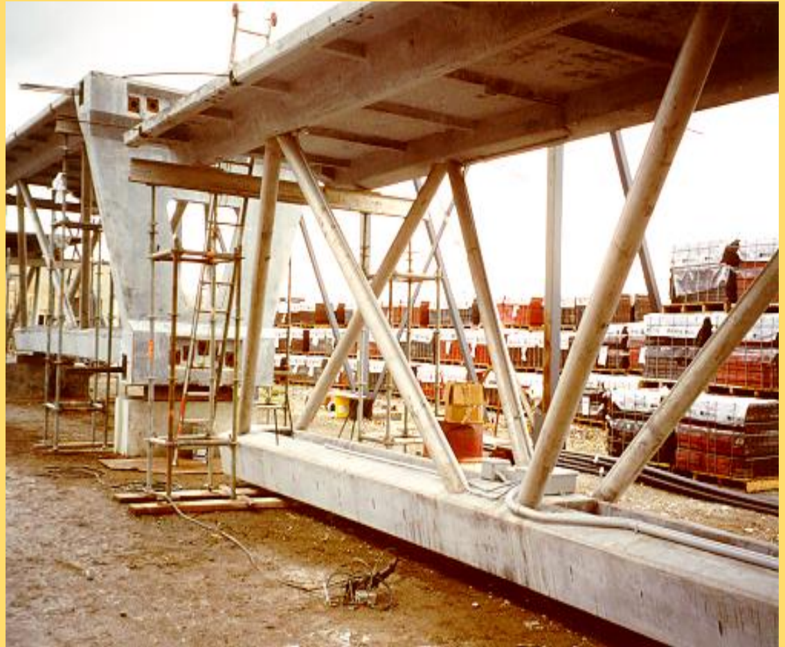
Passarela de Sherbrooke (Sherbrooke, Canadá)
