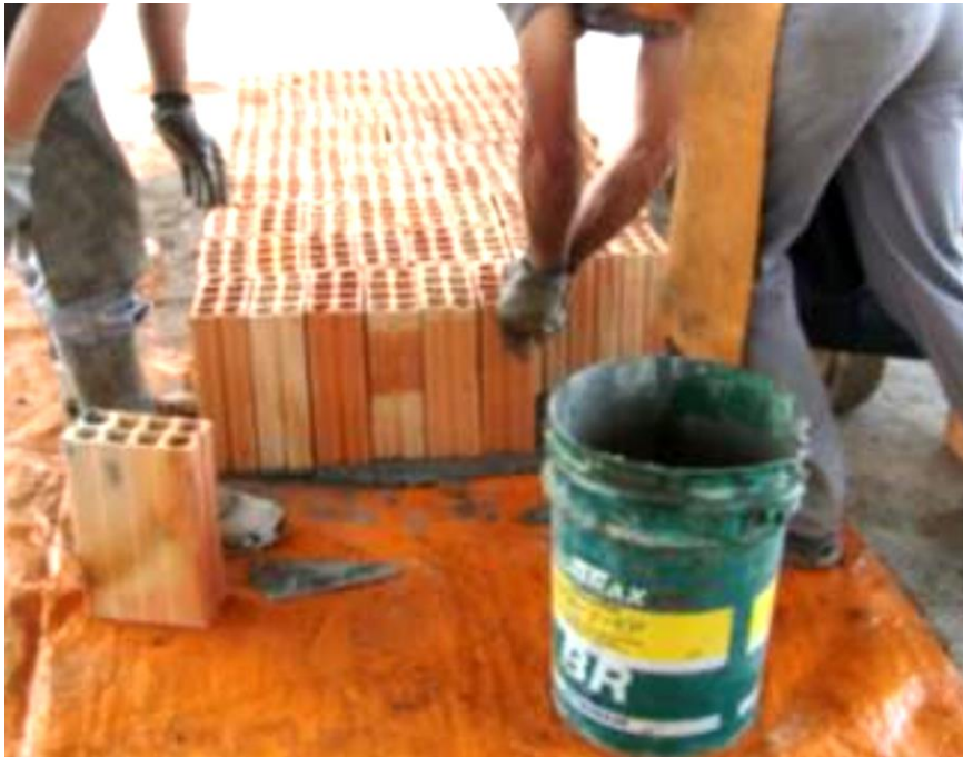
Tamponamento dos furos nas laterais dos blocos
