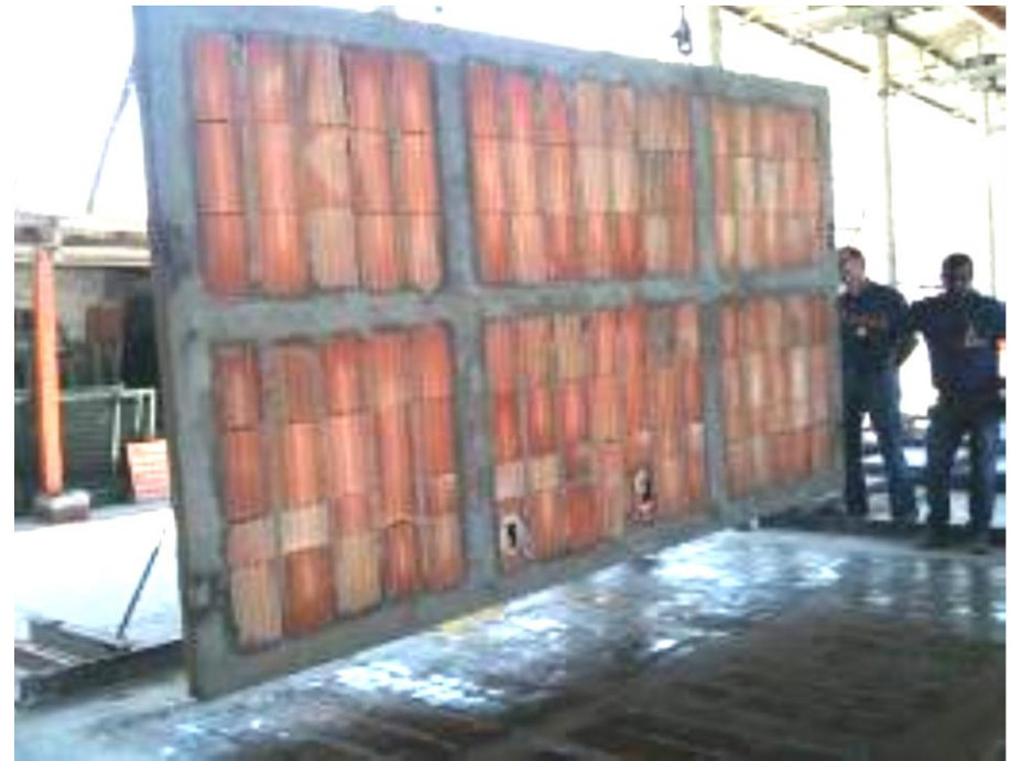
lçamento e armazenamento (8h ou f_{c,8h} \geq 15\text{MPa} )
