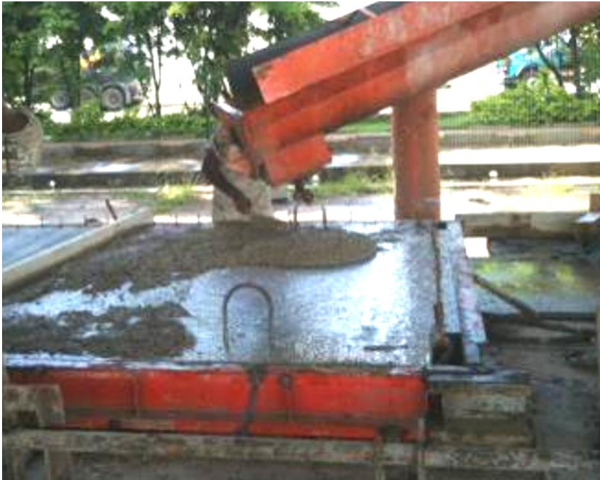
Lançamento camada de argamassa sobre o painel
