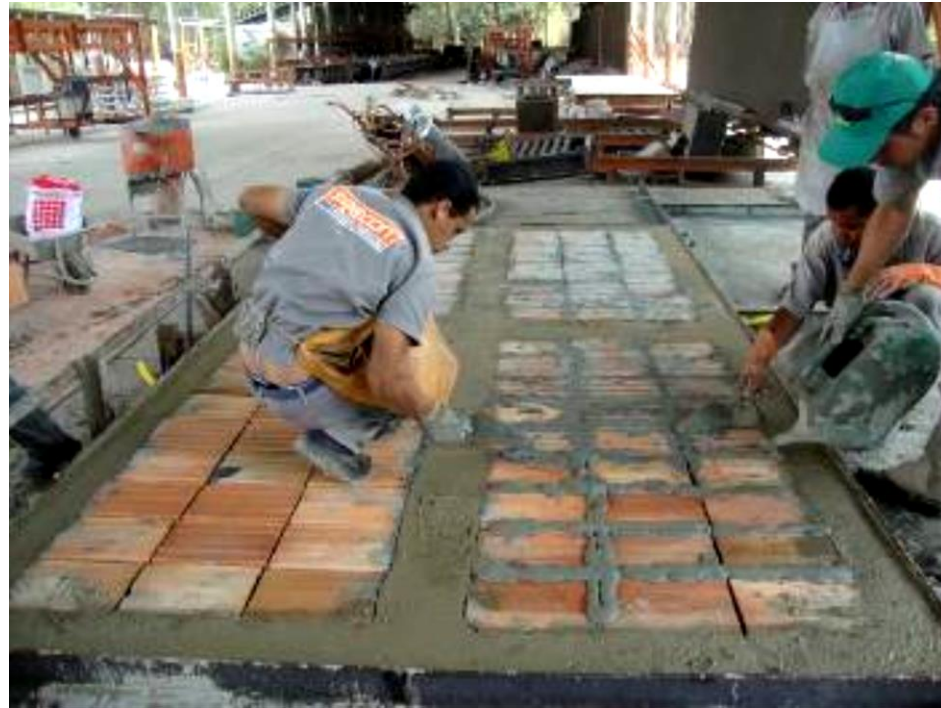
Lançamento da argamassa entre blocos
