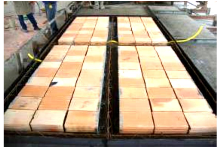
Posicionamento dos blocos, armaduras, conduítes de elétrica
