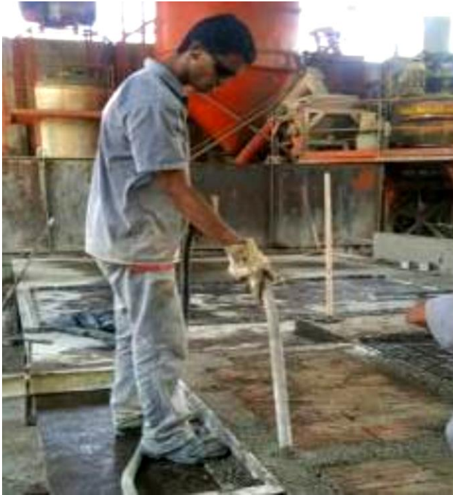
Lançamento e vibração do concreto das nervuras
