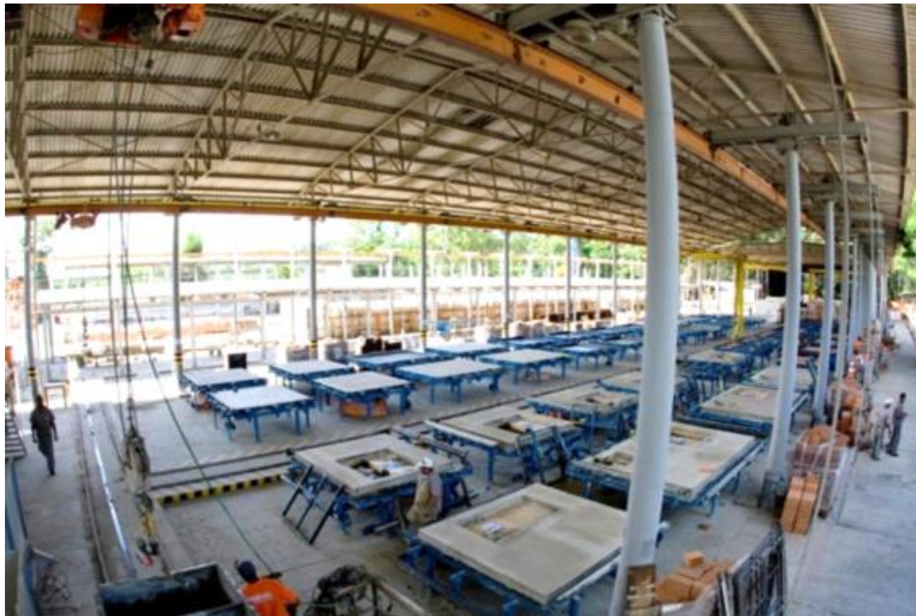
Linha de montagem totalmente remodelada (mesas elevadas vibratórias)
