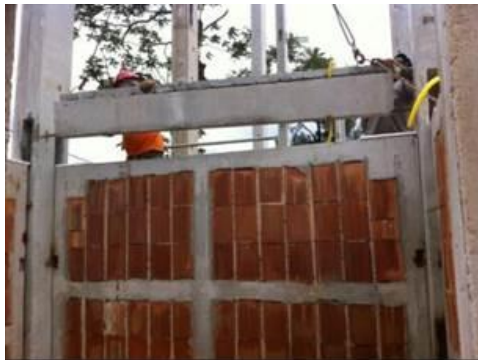
Posicionamento da viga pré-fabricada sobre placa de poliestireno (vão de 10mm)
