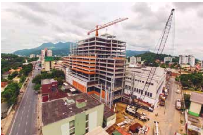
PRÉ-FABRICADO FOI O ESCOLHIDO PELA NECESSIDADE DE SE GARANTIR PRAZO DE CONCLUSÃO DA OBRA
