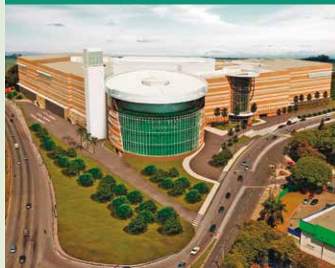
TIETÊ PLAZA: A OBRA DEMANDOU 25.000 M3 DE CONCRETO PRÉ-FABRICADO, CONSIDERANDO VIGAS, LAJES ALVEOLARES, PAINÉIS ARQUITETÔNICOS, ALÉM DE ESCADAS
