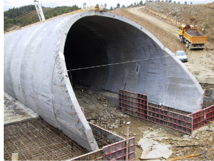
Túneis e Revestimentos
