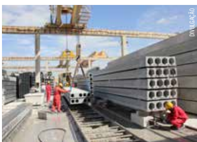
Lajes alveolares na fábrica da United Precast
