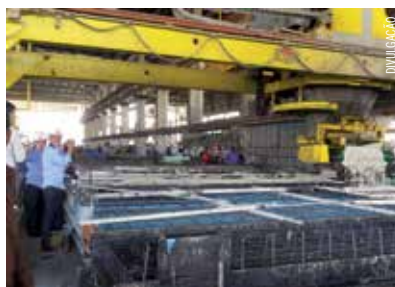
Lançamento do concreto na linha de painéis
