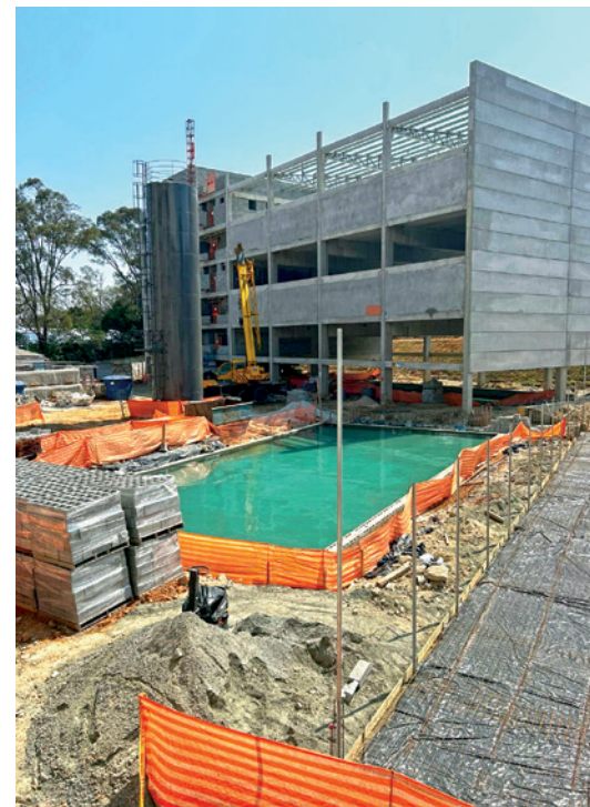
Organização de canteiro com restrição de acessos de pessoas não autorizadas e especialmente não ter colaboradores em baixo das áreas de montagem é fundamental
