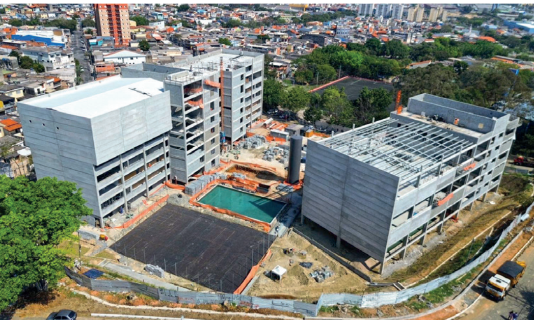
Organização de canteiro com restrição de acessos de pessoas não autorizadas e especialmente não ter colaboradores em baixo das áreas de montagem é fundamental
