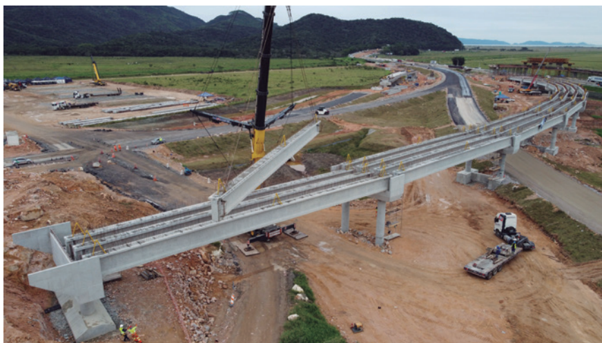
Para atender as demandas da obra, foi necessário montar uma pista de fabricação das estruturas no próprio canteiro de obras e a etapa de montagem exigiu a elaboração de um plano de rigging, com o uso de guindastes e conjuntos transportadores
