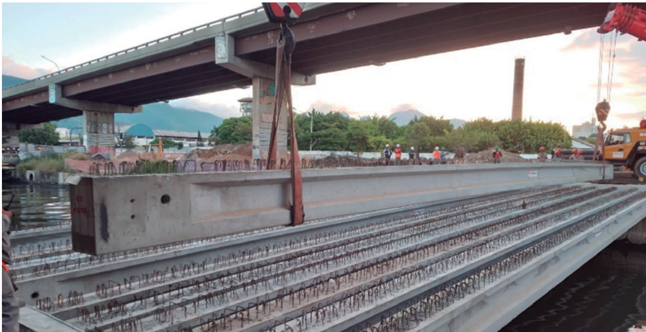
Montagem da ponte que teve como desafio a restrição na altura das vigas, limitadas a 70 centímetros para vencer o vão de 25,10 metros
