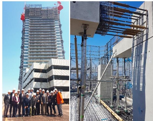
Fig.4 Missão Técnica Abcic 2019: visita técnica ao Ebina Station Condominium (a), com ênfase na execução das ligações (b)
