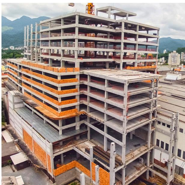
*Fig.1 Prédio com 65m, com estrutura integralmente pré-fabricada de concreto, em Jaraguá do Sul. Diferentes fases da montagem (a e b)*
