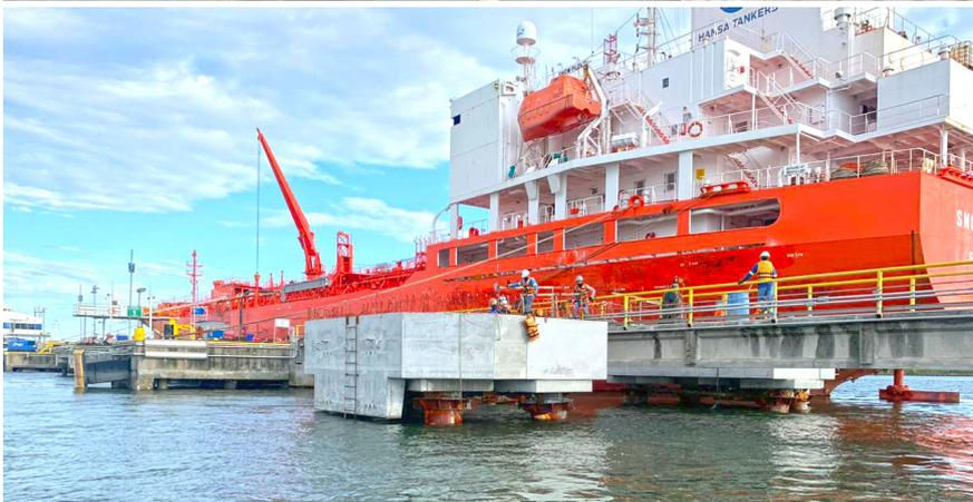
Elemento pré-moldado posicionado e concretagem final complementar realizada no local. O elemento funciona como forma
