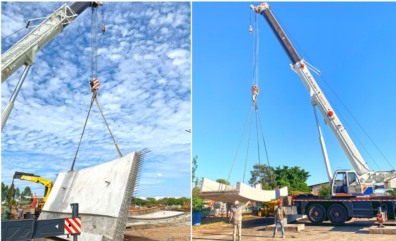
Transporte e montagem dos elementos pré-fabricados da obra do espessador de rejeito de minério
