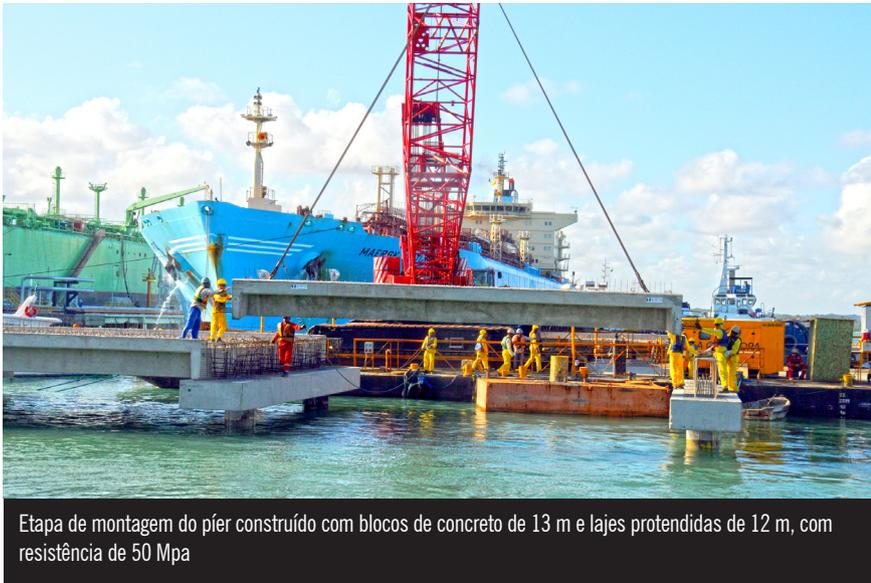
Etapa de montagem do píer construído com blocos de concreto de 13 m e lajes protendidas de 12 m, com resistência de 50 Mpa
