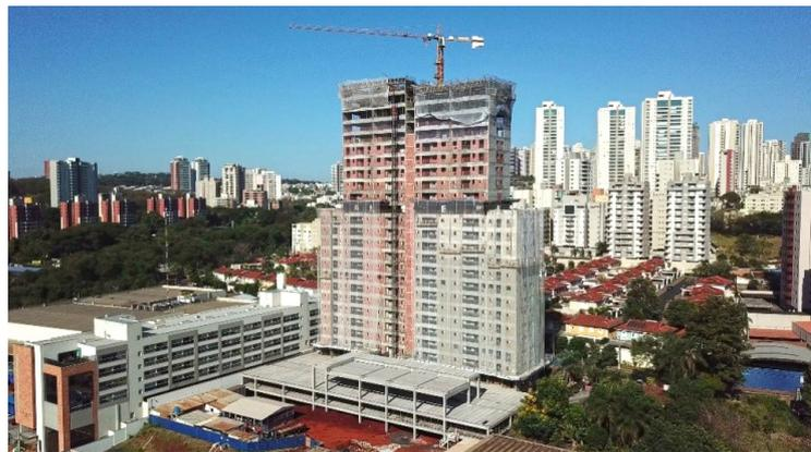
Fig 2. Edifício Varanda Botânico, Pré-Fabricado de Concreto, na fase de construção em Ribeirão Preto
