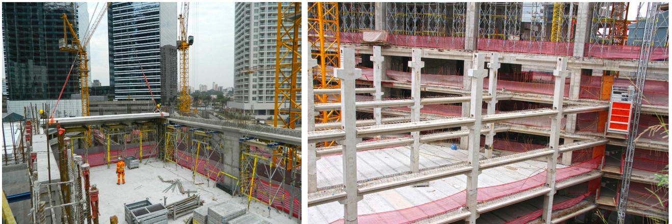
A solução estrutural adotada foi o sistema de pré-vigas e lajes alveolares com core trepante, gerando aumento de produtividade, industrialização da obra, controle de produção, estoque mínimos durante a execução e redução do custo da mão de obra e de execução.
