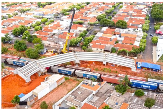
O sistema de peças pré-moldadas industrializadas permitiu a redução de 60% do efetivo de funcionários, diminuindo o risco de acidentes no local, e a redução de 30% do prazo
