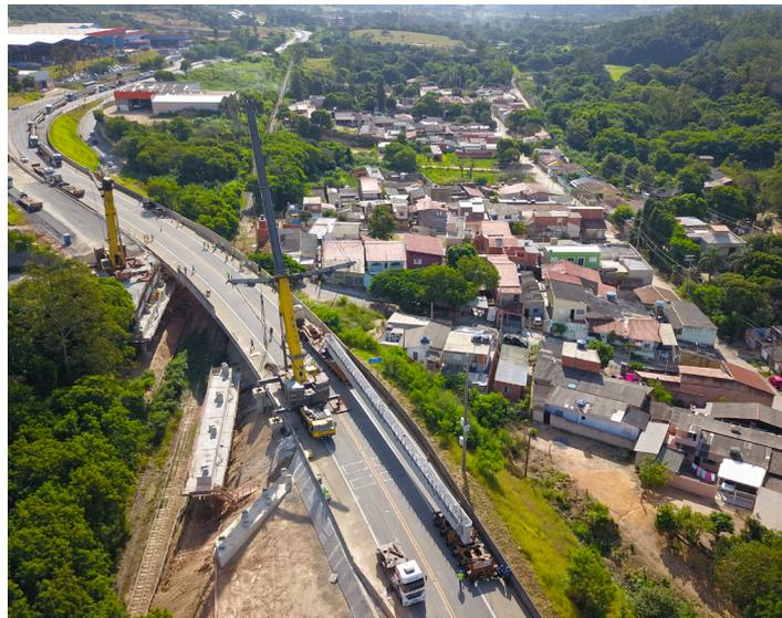
Catão Francisco Ribeiro, apresentaram um estudo alternativo adequando a obra para uma solução industrializada em vigas pré-moldadas de concreto protendido, sendo a maior viga com 45,90m de comprimento e peso de 112 toneladas, que reduziria o impacto sobre a linha férrea e para os usuários da rodovia, visto que a montagem das 12 vigas ocorreu em apenas 10 horas, minimizando o tempo necessário para desvio de tráfego.
