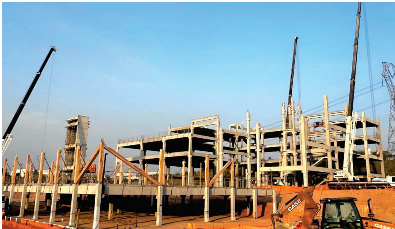
Obra se caracteriza pelo uso misto de estrutura industrializada em concreto pré-fabricado e madeira engenheirada, composta por camadas de madeira certificada de manejo responsável
