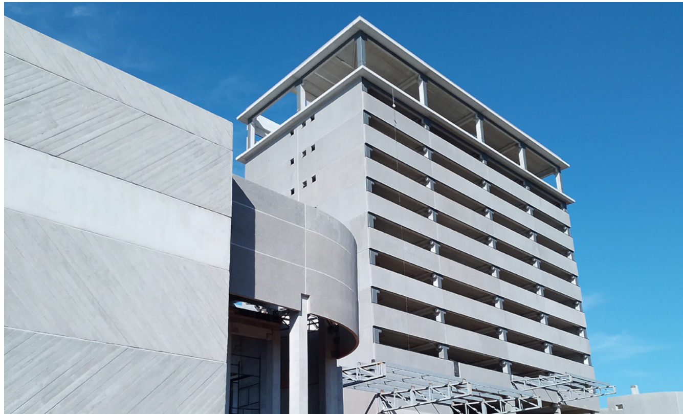
A estrutura do Hotel Terroà é 100% em concreto pré-fabricado, com painéis ocupando uma área de fachada de 4.781,8 m 2 e consumiram 572,301 m 3 de concreto armado. Foram utilizados 310 painéis arquitetônicos de vedação em todo o empreendimento
