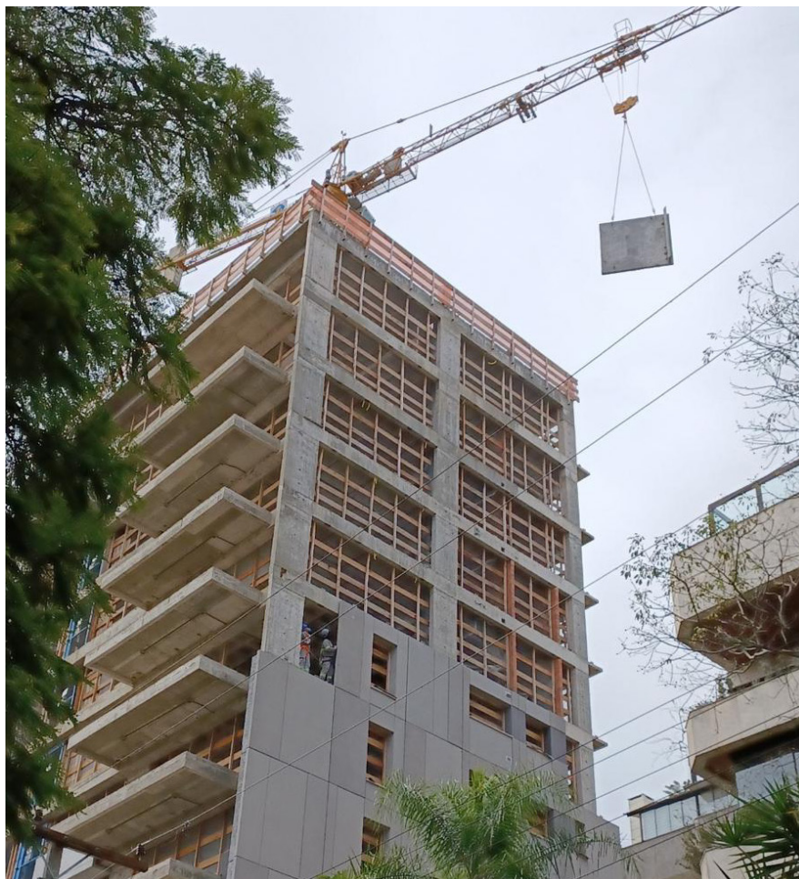
Os painéis foram produzidos em Barueri, na fábrica da Stamp, e levados ao canteiro, situado em Porto Alegre. Foram mais de 1.200 quilômetros de percurso, exigindo um planejamento rigoroso para garantir que cada peça chegasse ao destino em perfeitas condições e dentro do cronograma
