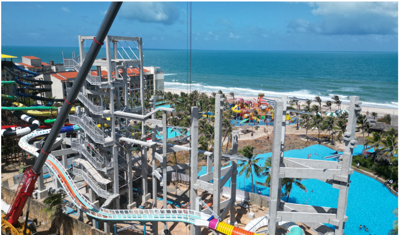
Para a montagem das peças, um guindaste de 300 toneladas ocupou toda a rua de acesso ao parque aquático, necessitando de sua interdição temporária, sendo utilizado para a montagem dos pilares, das vigas e das escadas
