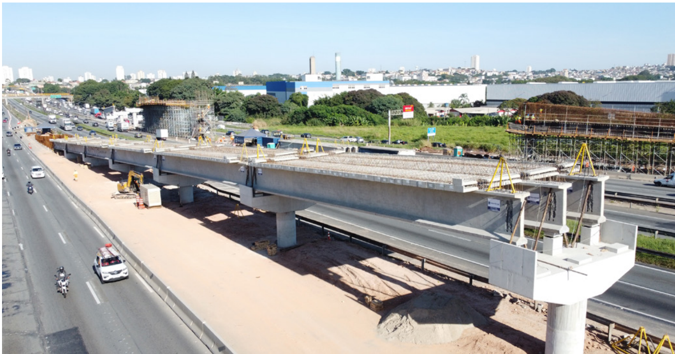
A obra, que conecta diretamente à Rodovia Fernão Dias, teve sua complexidade ampliada pela movimentação constante da rodovia. A utilização do máximo possível de estrutura em concreto pré-fabricado foi a solução que reduziu e facilitou a execução da obra
