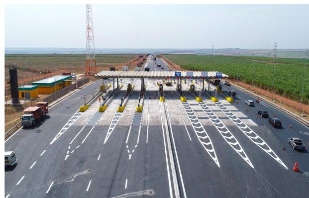
Foto 6: Praças de pedágio pré-fabricadas de concreto
