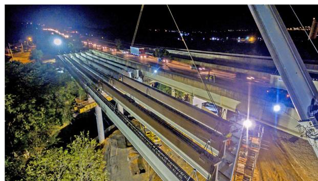
*Foto 8: Montagem das estruturas pré-fabricadas de concreto em rodovia em São Paulo no período noturno*
