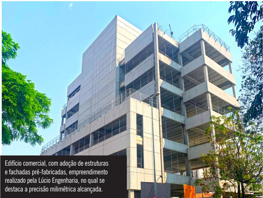
Edifício comercial, com adoção de estruturas e fachadas pré-fabricadas, empreendimento realizado pela Lúcio Engenharia, no qual se destaca a precisão milimétrica alcançada.
