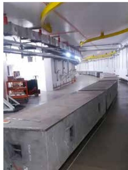
Tecnologia da pré-fabricação, aplicação de concretos especiais e precisão na base asseguram os requisitos específicos no Projeto Sirius.
