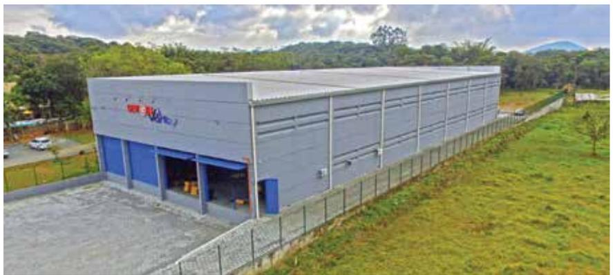
Vão livre de 25m com Viga I protendida e painéis lisos com encaixe junta seca 10m
