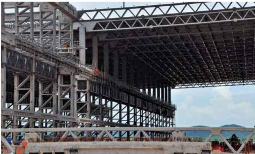
Estaleiro Paraguaçu (BA): pilares e vigas treliçadas produzidas com elevada precisão dimensional possibilitada pelo desenvolvimento de formas especiais e tecnologia do concreto
