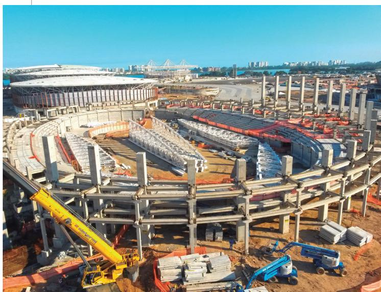
Figura 3 - Velódromo e no fundo as arenas Carioca 1,2 e 3 também foram construídas em estruturas pré-fabricadas de concreto
