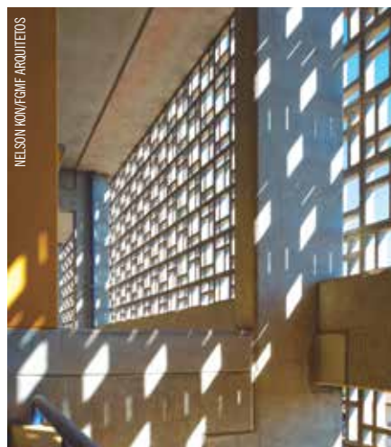
Escola construída pela Fundação para o Desenvolvimento Escolar (FDE) em Várzea Paulista/SP permitiu soluções construtivas harmonizadas com o projeto arquitetônico
