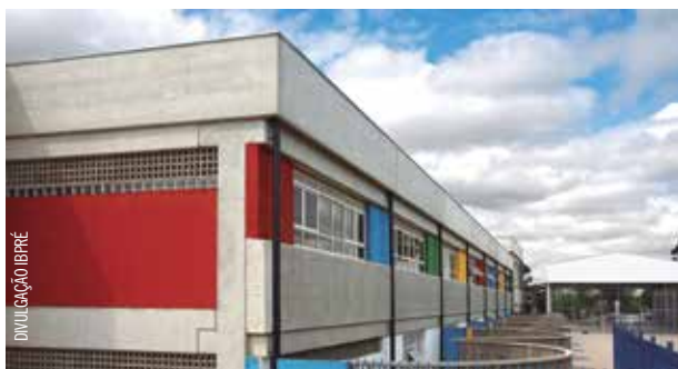
EMEF Vila Nova Artigas, na capital paulista: projetos arrojados em escolas são possíveis com o uso de estruturas pré-fabricadas de concreto
