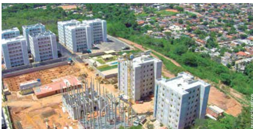
Solução criada pela Precon virou case da Fundação Dom Cabral por seu um marco na construção industrializada e sustentável de moradias populares
