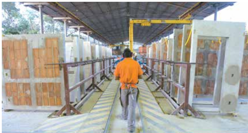
Fábrica de painéis da solução habitacional Precon ambiente coberto e rigorosamente controlado
