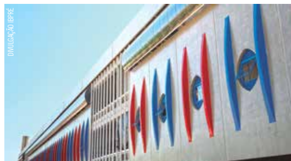
ETEC Paraisópolis-São Paulo: estruturas pré-fabricadas de concreto combina construção segura com beleza plástica na fachada
