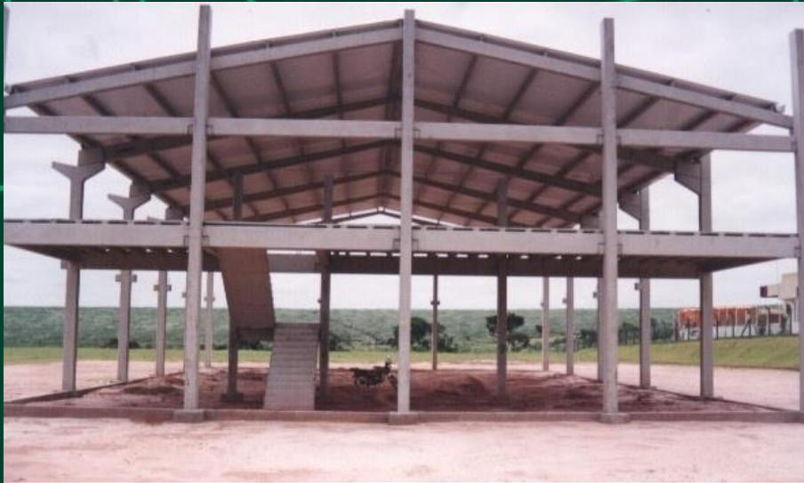
**Pórticos (estrutura de cobertura integrada ao sistema).**
