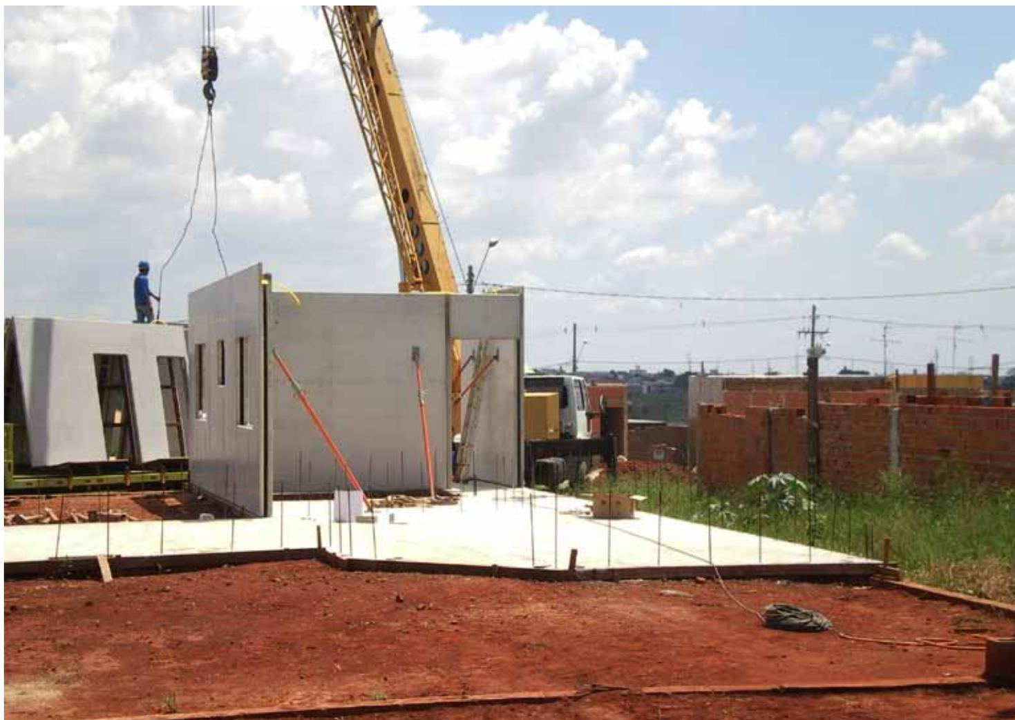
■ Residências sendo construídas com o sistema de paredes duplas
