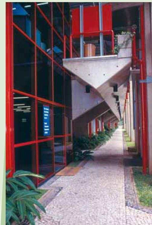
■ Estrutura pré-fabricada desponta como layout diferenciado do edifício da Brastemp, projetado por Sidônio Porto
