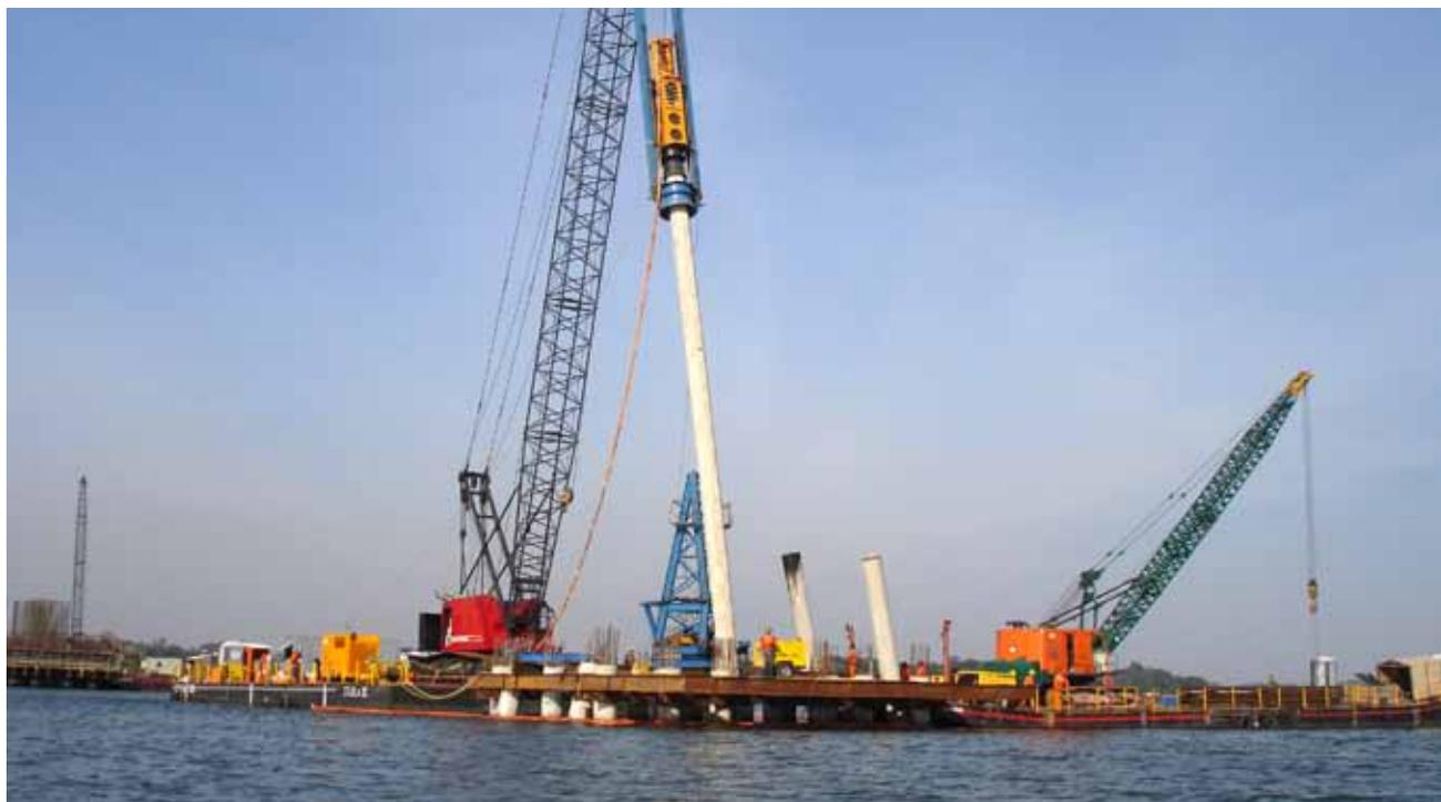
■ Estacas-pré fabricadas de concreto sendo cravadas em obra marítima. São tecnologias adequadas, inclusive, para meios altamente agressivos
