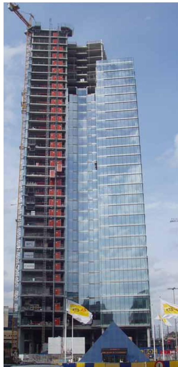
■ Dexia Tower - Edifício na Bélgica de 37 pavimentos em sistema misto com núcleo rígido e estrutura periférica em pré-fabricados de concreto
