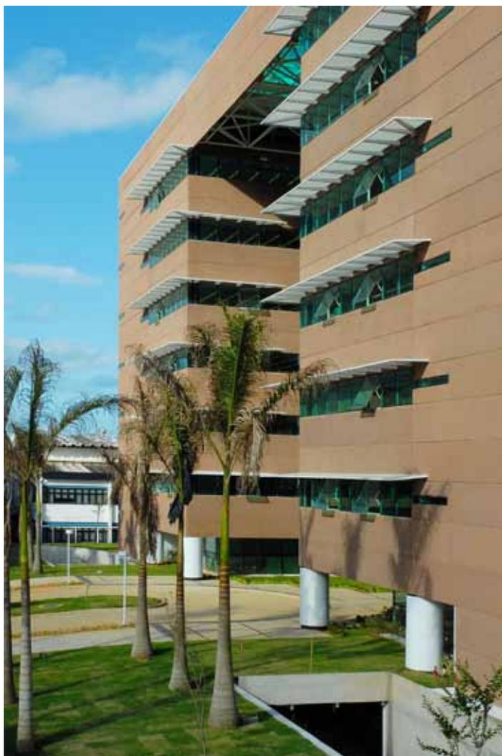
■ Visando a conservação de energia, projeto leva quebra-sóis sobre as faixas envidraçadas, painéis alveolares e vidros laminados nas vedações
