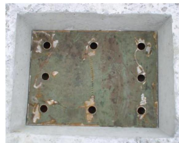
**Detalhe de conexão com vigas metálicas**
